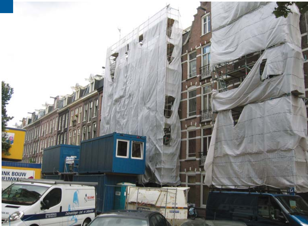
Renovatie van woningen in de Kanaalstraat in Amsterdam
