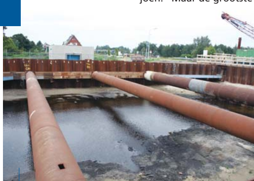
Water wegpompen voor aanleg N201
