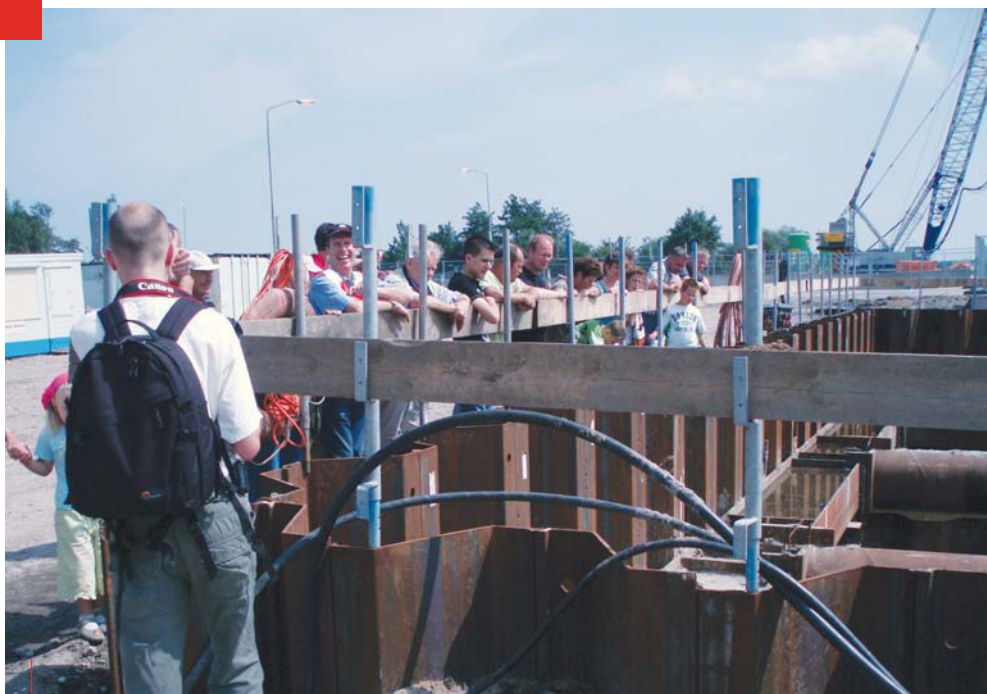
Open dag bij de bouw van de tunnel onder het Drontermeer
