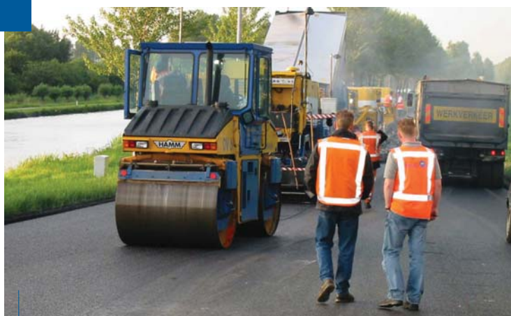
Onderhoudswerkzaamheden aan de weg N207 bij Alphen aan de Rijn
