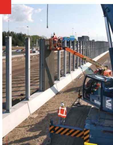
Plaatsing van geluidsschermen langs de A2
