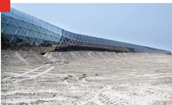
In het geluidsscherm 'De Cockpit' is een autoshowroom gevestigd
