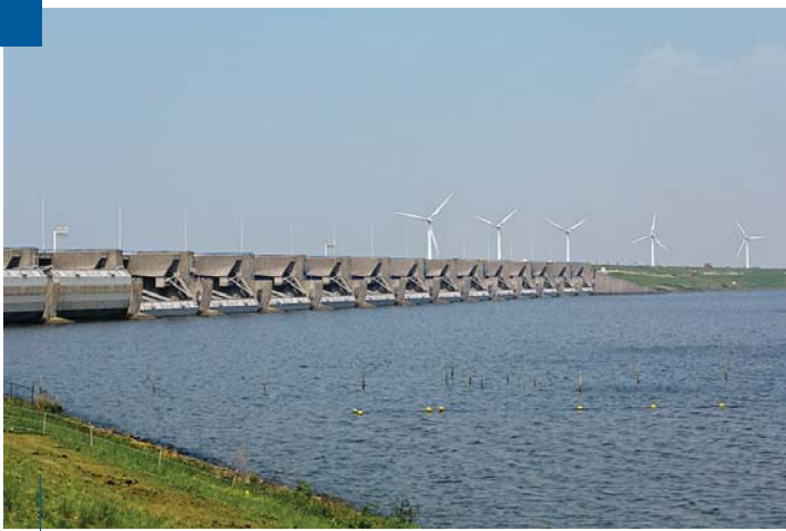
Het Haringvliet verzilt met het openen van de sluisen
