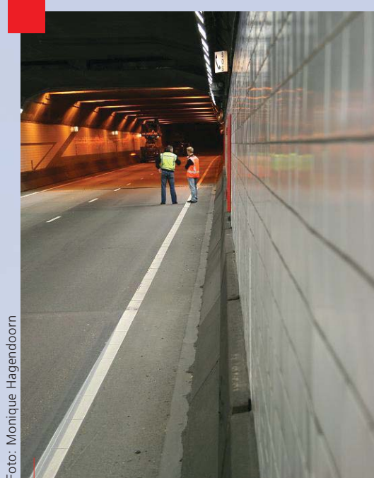
Het onderhoud aan de bestaande tunnel wordt ook verzorgd door Coentunnel Construction
