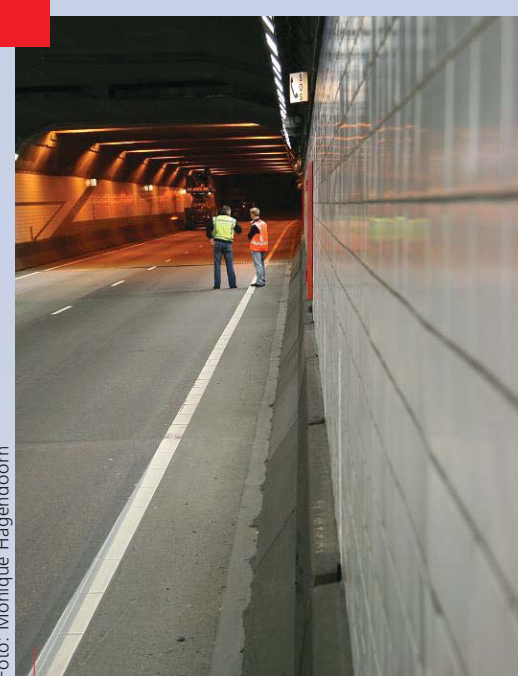
Het onderhoud aan de bestaande tunnel wordt ook verzorgd door Coentunnel Construction
