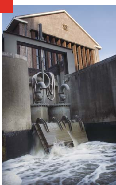
Uitlaat gemaal Zaaijer
